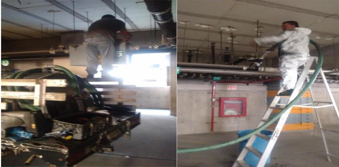
❑ **DESAZOLVE DE RED DE TUBERIA QUE CONDUCE TODOS LOS DESECHOS GENERADOS DEL AREA DE ANFITIATRO (AGUAS ROJAS Y AGUAS UTILIZADAS PARA EL LAVADO DE CAMILLAS, LIMPIEZA DE PISOS Y CUERPOS.**
