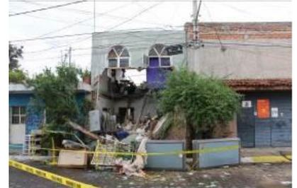
**5.-** 25 de Julio, se acude a la municipalidad de Zapopan, lugar donde se registró una explosión por acumulación de gas l.p. el cual se fugó de la toma alimentadora de la estufa ubicada en el área de cocina, debido a una conexión inadecuada, resultando la destrucción parcial de la finca, donde falleció una persona del sexo masculino y una femenina resultó con lesiones por quemaduras, misma que fue rescatada entre los escombros.
