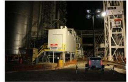
**4.-** 21 de Julio, se acude a una Termoeléctrica en la municipalidad de Zapotlanejo, lugar donde se registró una explosión en un ducto ubicado en el área de recuperación de calor, mismo que trabajaba con vapor de agua, produciéndose este por el mal manejo de las válvulas al ser este un circuito cerrado, ocasionando un golpe de ariete resultando fallecida una persona del sexo masculino y cinco personas más resultaron heridas.
