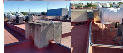
2.17 Arranque y pruebas de equipo de purificación de aire compuesta con ductería, sistema de extracción, filtros de carbón activado, banco de ozono, banco de luz ultravioleta, cortina de agua y sistema de distribución de aire.
