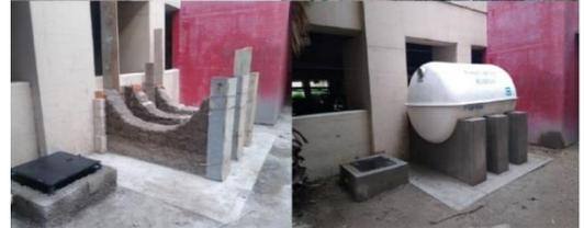
2.7 Instalación de soportes, trampa de grasas y tubería de línea de descarga sanitaria con conexión a tanque septico.
