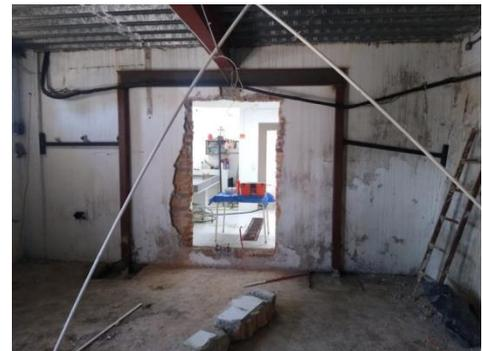
3.2 Abrir muro y reforzar con estructura metálica y colar zapatas de estructura con concretos para instalación de puerta de ingreso a cuarto frío.
