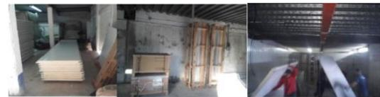
3.9 Armado de cuarto frío con multipanel térmico paredes, techo, puerta de ingreso, luminarias internas e instalación de difusores.
