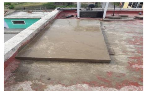
3.6 Adecuación de base de concreto para la instalación de 2 unidades de refrigeración del cuarto frío.
