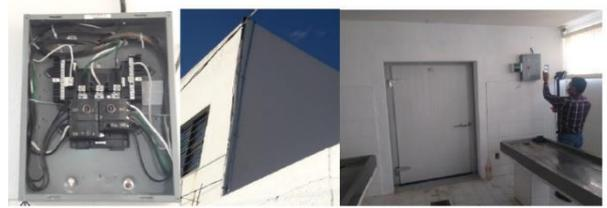
3.8 Adecuación y/o modificación al circuito de línea eléctrica externa de Comisión Federal de Electricidad con el objetivo de obtener 220 a 228 volts, requeridos para el buen funcionamiento del sistema de refrigeración del cuarto frío.
