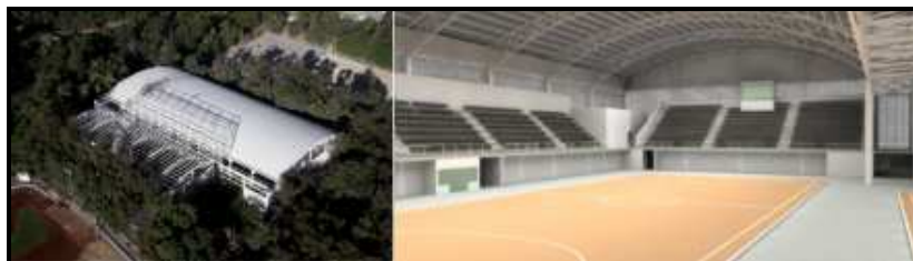
CONCLUSIÓN DEL GIMNASIO DE BALONMANO EN LA UNIDAD DEPORTIVA SAN RAFAEL
