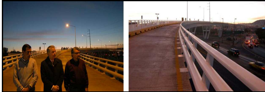
CONCLUSIÓN DEL PUENTE EL ÁLAMO
