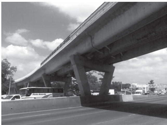
Paso elevado Colón y Periférico.
