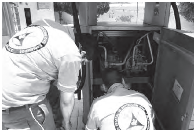
Inspectores verificando medidas de seguridad en instalaciones
