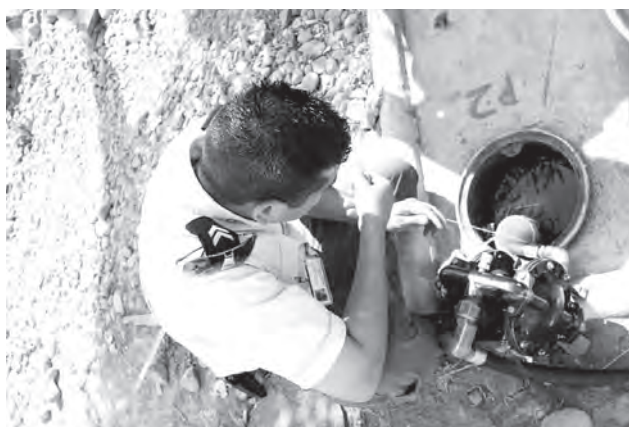
Toma de muestras para evaluación de condiciones de riesgo
