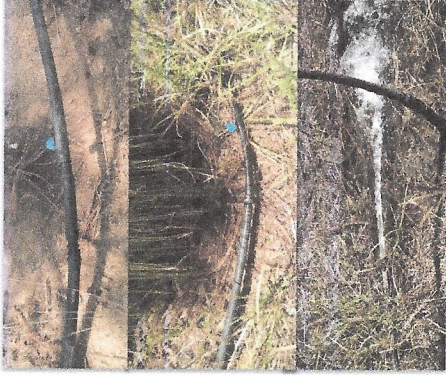
Mantenimiento al sistema de riego del Huerto Semillero.
