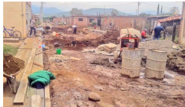
– Empedrado ecológico con huellas de concreto en la Calle Francisco Villa en San Andrés
