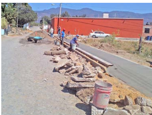
— Banquetas en la colonia Reforma
