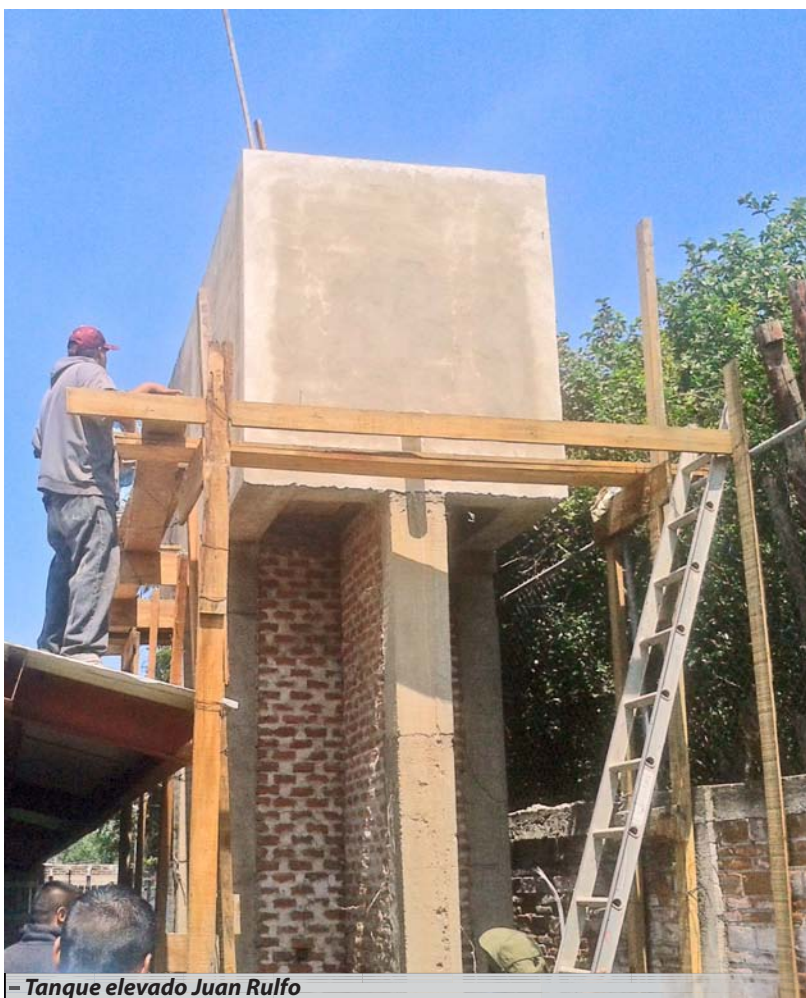
- Obras de drenaje en la colonia El Fresno
