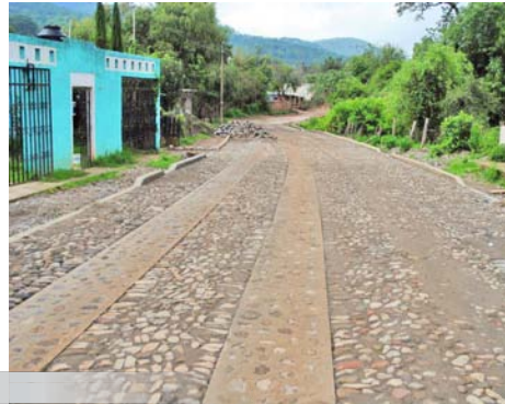
– Empedrado ecológico con huellas de concreto en Prolongación de Obregón en San Andrés
