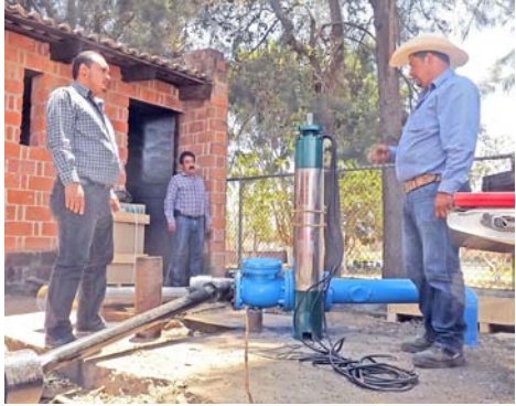
– Construcción de baños en San Nicolás
