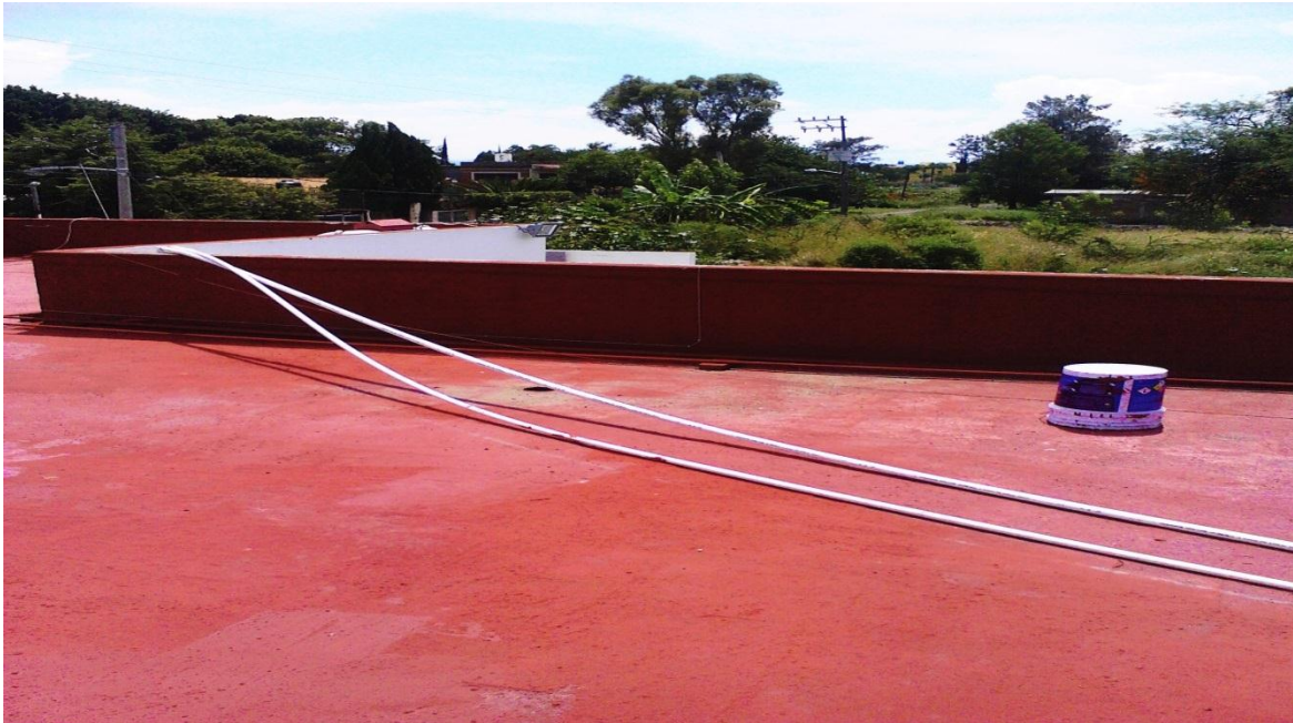
INSTALACIÓN DE 3 TRITURADORES ELÉCTRICOS EN PLANCHAS DE NECROPSIAS DELEGACIÓN OCOTLÁN.
