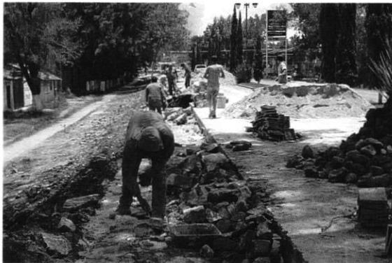
Se realizan labores de despalme, apertura de cajones y retiro de material inadecuado, conformación de sub-base y base, rehabilitación de líneas de drenaje y agua potable, así como la construcción de superficie de rodamiento a base de empedrado ahogado en concreto. Todo esto con una inversión de **\$4,000,000.00**
