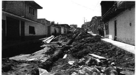
Introduciendo 228 m.l. de red hidráulica de pvc de 3" y la misma longitud de tubería sanitaria de 10", realizando tomas y descargas domiciliarias, pozos de visita y cajas de válvulas para su correcto funcionamiento, además de 1,641.77 m2 de empedrado ahogado en concreto
