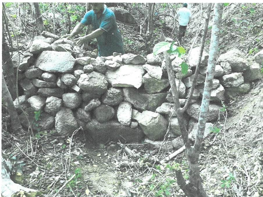
Ejemplo: Presa realizada.
