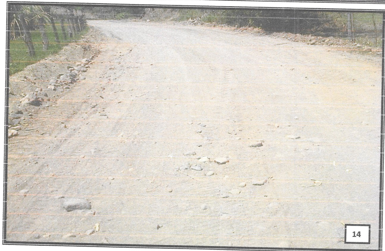
Fotos 11, 12, 13 y 14. Conservación y mantenimiento de caminos en el N.C.P.E. Las Ramas, Municipio de Casimiro Castillo, Jalisco
