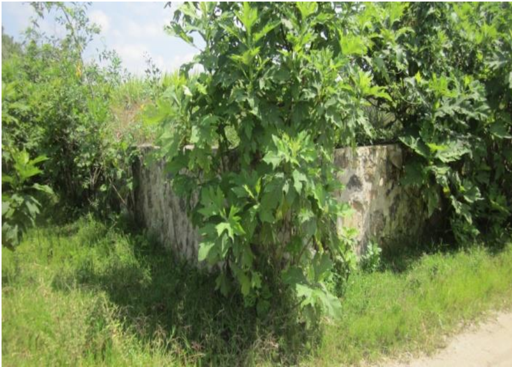
Condición actual de cubrimiento parcial del avance de construcción de la caseta de control en el sitio conocido como La Tecomata .....
