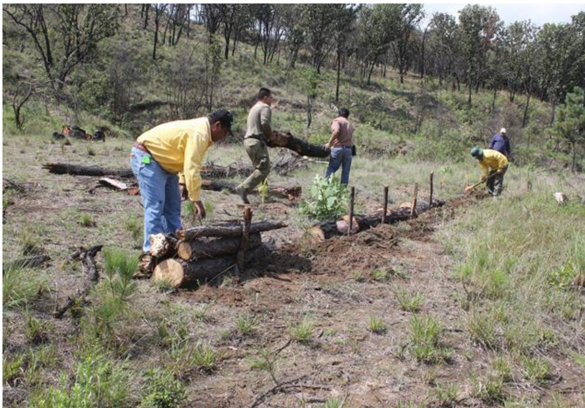
Fig. 03 trabajos de acordonamiento de la madera.
