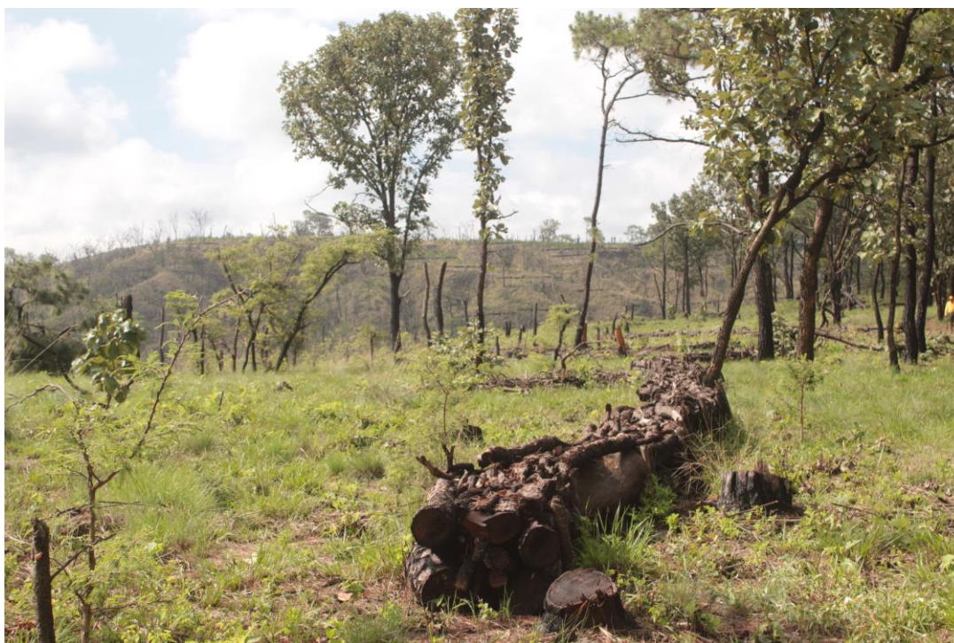
Fig.04 Construcción de cordones de madera siguiendo las curvas de nivel
