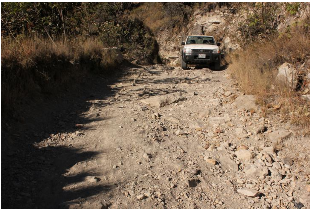
Figura 4.- Se muestra las condiciones de erosión que impiden el tránsito a vehículos.
