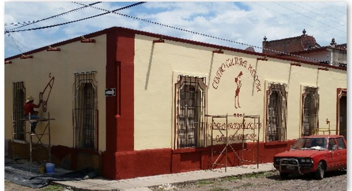
\* Mejora y mantenimiento al edificio Casa de la Cultura Mas-cota, mediante los trabajos de colocación de loseta, impermeabilizado, resanes en muros y cielo, pintura en el interior y
