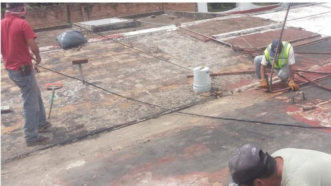
\* Apoyo de mano de obra a la mejora de las instalaciones que ocupa IDEFT, mediante demolición de muros, resanes e impermeabilización.
