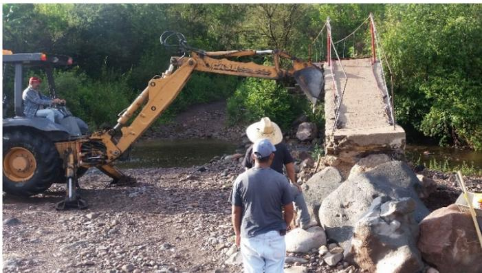
\*Rehabilitación de puente peatonal en la comunidad de El Agostadero, Estabilización de base de piedra y construcción de aleros, rehabilitación de cable de acero y soportes.
