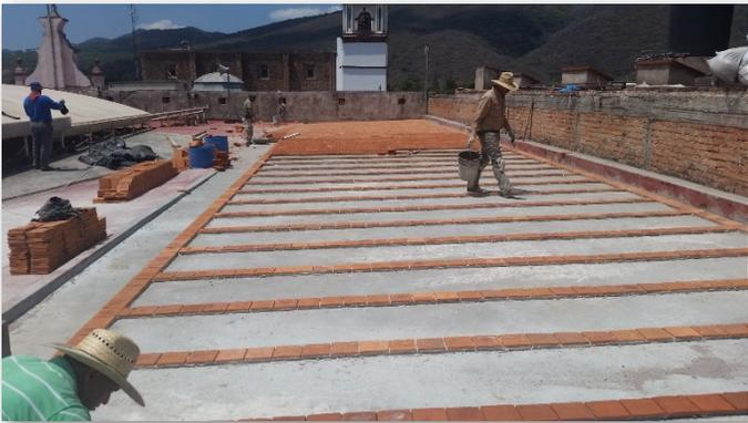
\* Rehabilitación de 250m<sup>2</sup> de losa de azotea en el edificio de Presidencia Municipal, demolición de loseta existente, re-nivelación con jalcreto y colocación de loseta.
