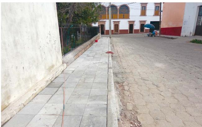
trabajos de mantenimiento y rehabilitación en la pintura de bancas y el kioskito de la plaza principal; en este mismo proyecto se retiró el material de las banquetas ya existentes de la Casa de Pastoral y de enfrente del Templo para colocar losetas a base de piedra volcánica.
