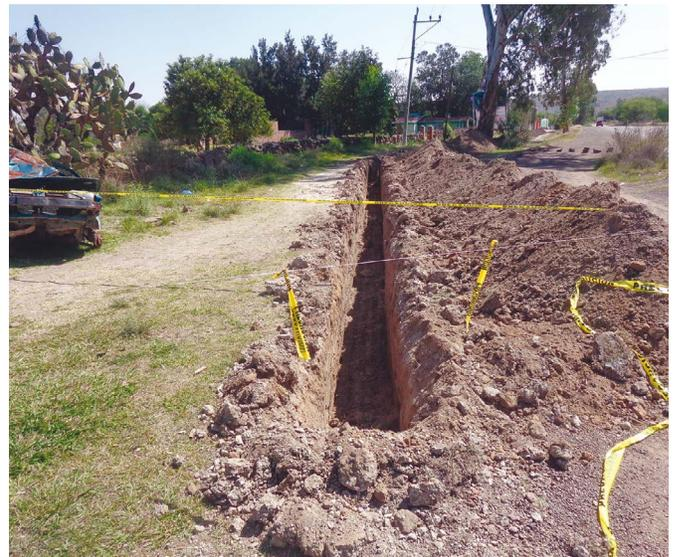
ción de agua potable en la que se sustituyó a la antigua red de agua que va del pozo de abastecimiento al depósito.
