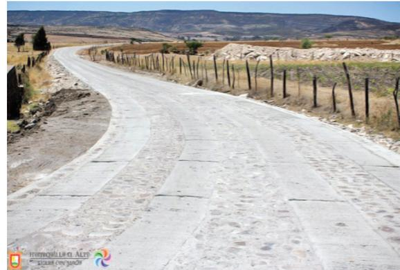
**“PAVIMENTO DE 2KM CON HUELLAS DE CONCRETO HIDRÁULICO Y EMPEDRADO ECOLÓGICO EN EL CAMINO A LA COMUNIDAD DE RANCHO COLORADO, EN EL MUNICIPIO DE HUEJUQUILLA EL ALTO, JALISCO.”**
