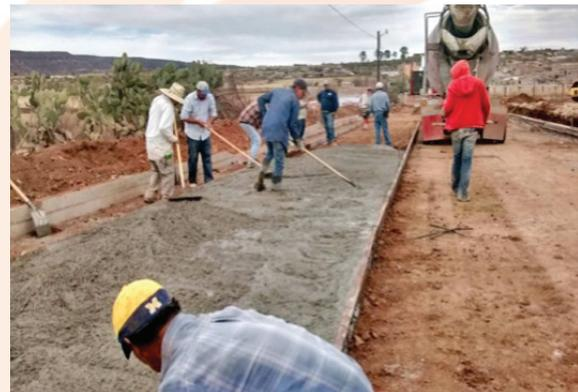
**“MODERNIZACIÓN DE TRAMO EN CAMINO A LA COFRADIA CON HUELLAS DE CONCRETO Y EMPEDRADO ECOLÓGICO EN EL MUNICIPIO DE HUEJUQUILLA EL ALTO, JALISCO.”**
