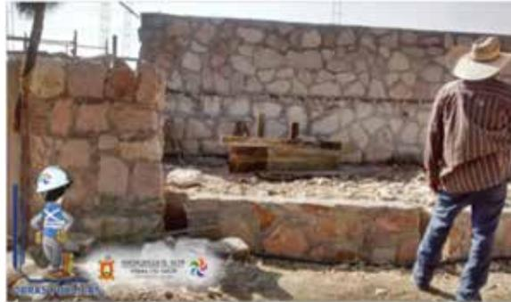
Se realizó la construcción de piso firme de concreto hidráulico en una superficie de 150 m<sup>2</sup> para el patio de la capilla en la comunidad de los Zapotes. El Gobierno Municipal apoyo con materiales de construcción y beneficiarios aportaron la mano de obra.
