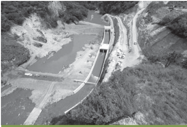
Canal de desvío, municipios de Ixtlahuacán del Río y Zapotlanejo
