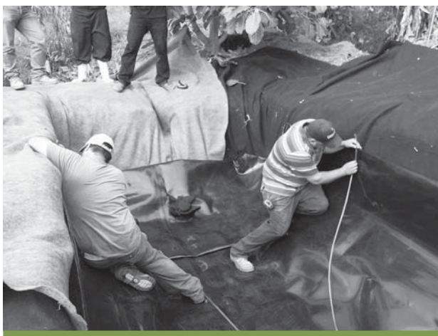
Instalación de biodigestores, Gómez Farías
