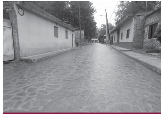
Obra de empedrado de calle
