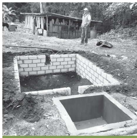
Instalación de biodigestores, Tamazula
