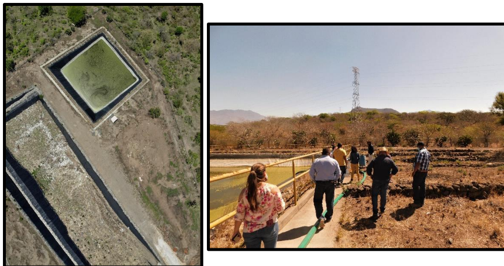
Figura 21. Vista aérea de la celda de disposición final y la fosa de lixiviados del relleno sanitario del municipio de Hostotipaquillo (izquierda); recorrido de campo realizado por personal de la JIMAV, SEMADET y del H. Ayuntamiento de Hostotipaquillo (derecha).
