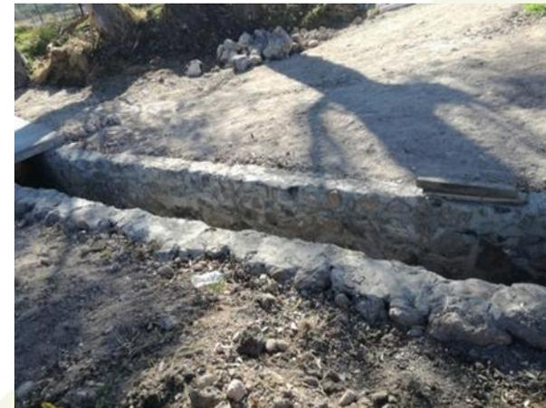
*CANAL DE CONTROL DE DEMASÍAS PLUVIALES*
