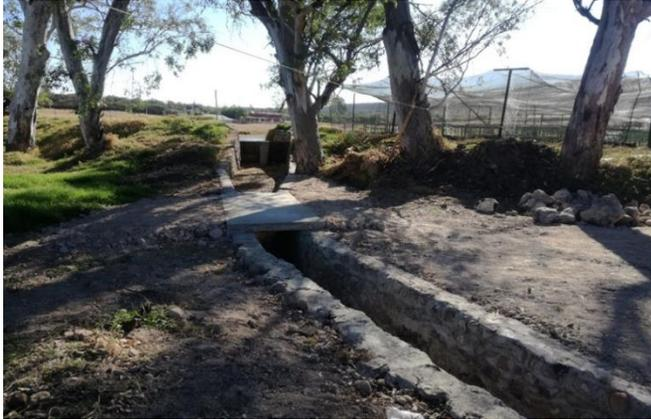
**Fotos 2.2.4** Obra de conducción de demasías pluviales producción
