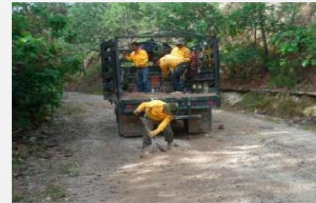
| Reparación de caminos
