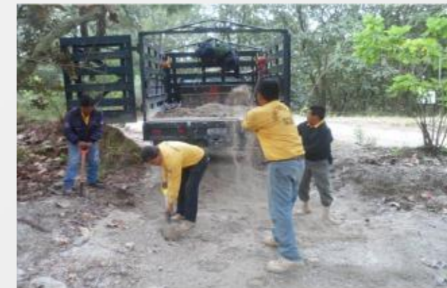
| Reparación de caminos
