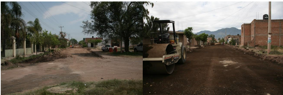
Pavimentación de la Calle Guamúchil en la Col. Los Mezquites.
