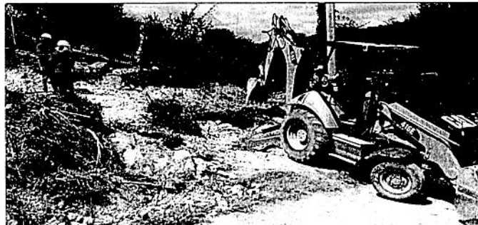
LIMPIEZA CON EQUIPO PARA TRAZO DE LINEA DE ALIMENTACION.
