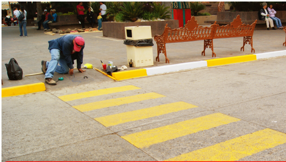
Balización de calle madero a un costado de la Plaza Principal
