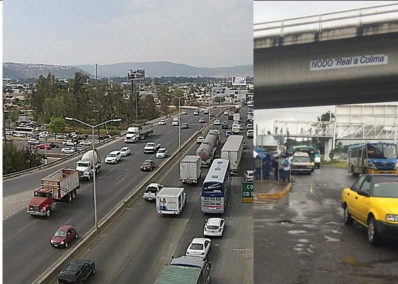
Fotografía II.6. Nivel de Servicio “D” Situación Actual. Anillo Periférico Sur y su intersección con Camino Real a Colima
