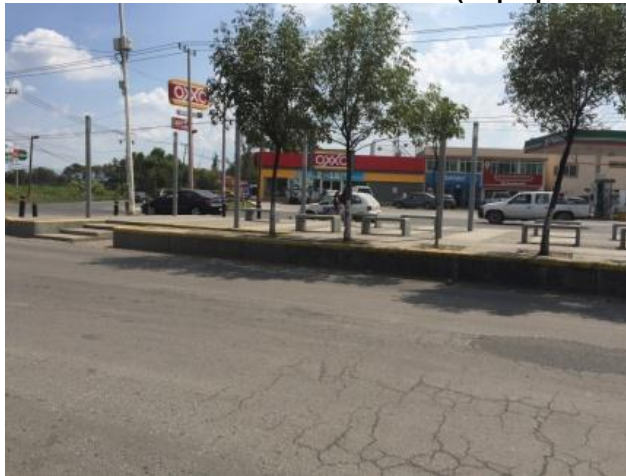
Fotografía II.3. Av. Adolf Horn en su cruce con Av. Concepción (adecuación geométrica y semaforización).
