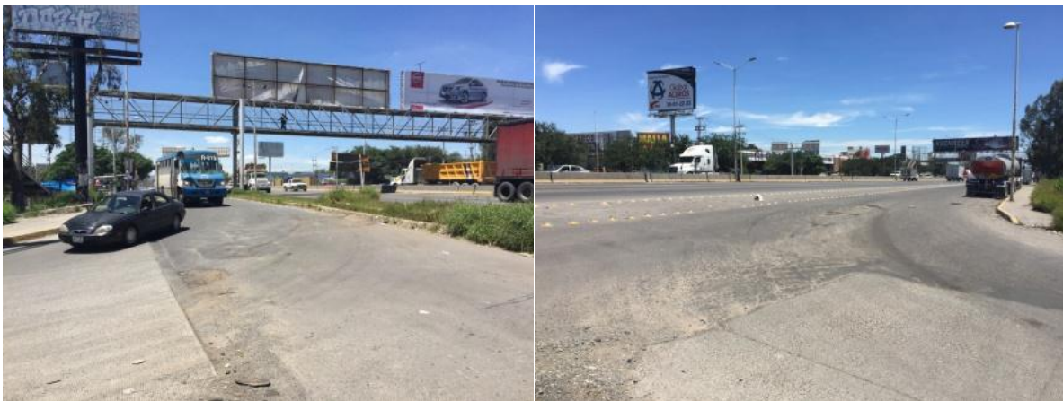
Fotografía II.8. Componentes y elementos. Incorporación de Periférico a Av. Adolf B.Horn y Entronque Av. Adolf Horn- Periférico. Situación Actual
