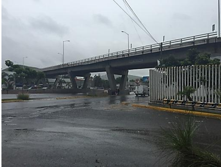
Fotografía II.7. Componentes y elementos. Nodo vial PeriféricoSur y Av. Camino Real a Colima. Situación Actual
