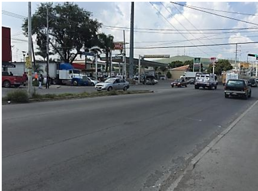
Fotografía II.1. Calle Juan Álvarez en su intersección con la Av. Adolf B. Horn (se plantea cambio de sentido vehicular).
