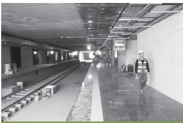
Estación Periférico Norte
