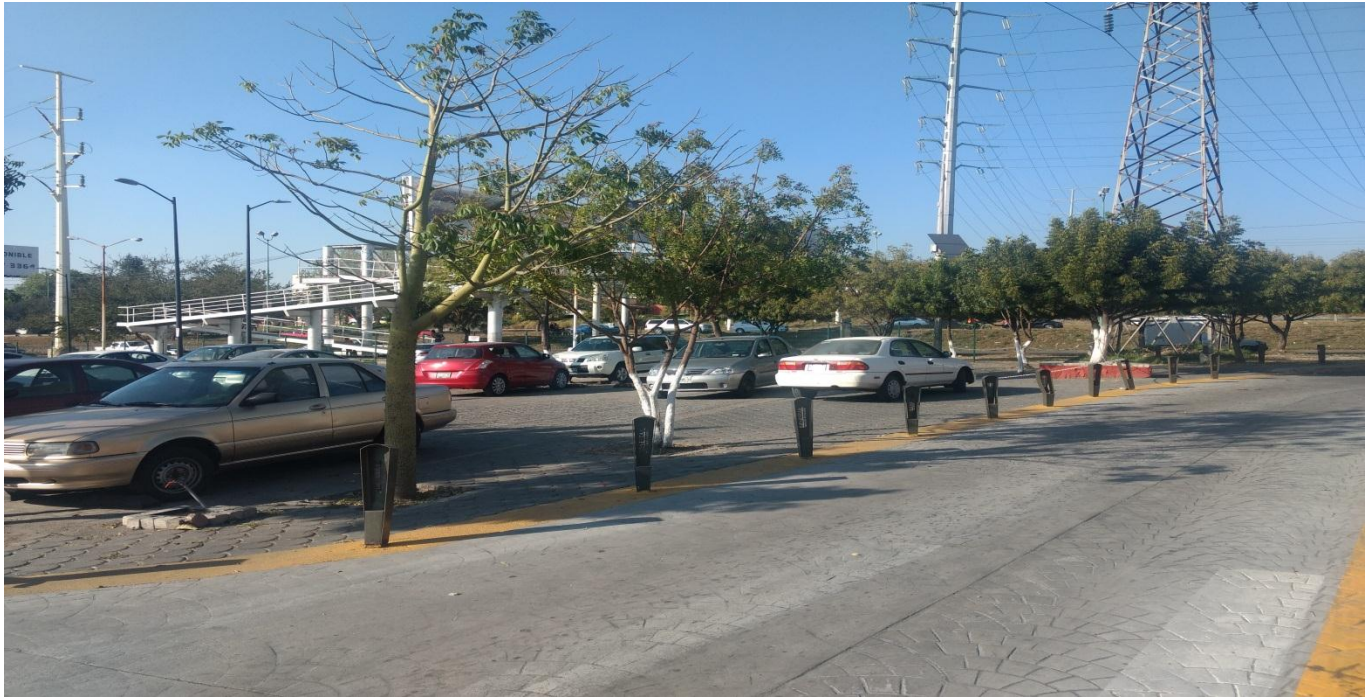
❑ REPARACION DE BOLARDOS Y REPARACION DE JUEGO INFANTIL.
