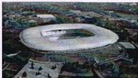
Estadio Omniflife: Red Eléctrica Media y Baja Tensión.
