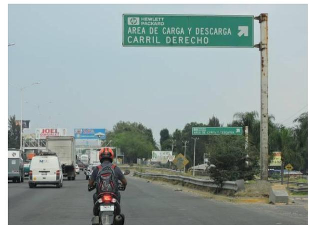
VISTA DEL ANILLO PERIFÉRICO HACIA EL INGRESO A LA NAVE INDUSTRIAL DE HP, SE APRECIAN LAS CONDICIONES DEL ACOTAMIENTO Y DE LA BARRERA LATERAL EN ESTADO REGULAR.
