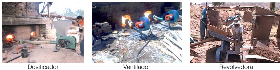
Figura 6.18: Maquinaria y equipo auxiliar utilizada en la producción ladrillera Fuente: Elaboración propia, 2017.
