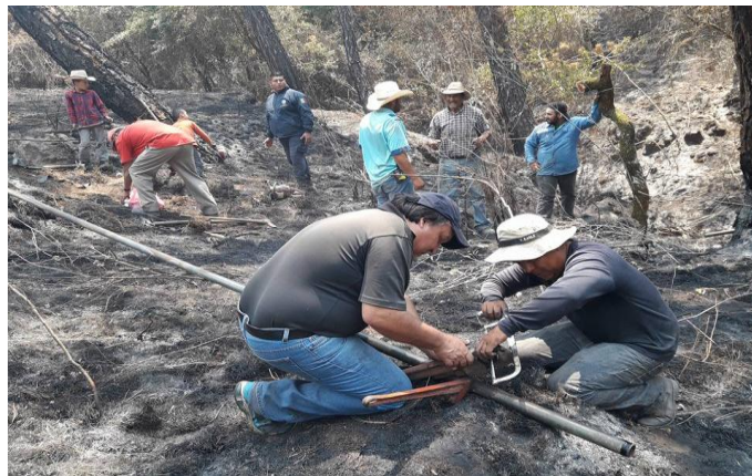
REPARACION DE LA LINEA DE AGUA EN LA AGENCIA DE LOS OCUARES
