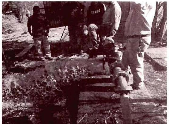
Se apoyó en esta población con la instalación de una bomba sumergible nueva del pozo de esta comunidad, ya que la que existía no abastecía lo suficientemente.
