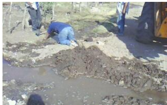
En la parte del interior de la cabecera 29 se han reparado y sustituido por tomas nuevas domiciliarias de agua, debido al desgaste por el tipo de material con el que cuentan.
