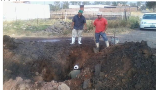
En la parte del interior de la cabecera 29 se han reparado y sustituido por tomas nuevas domiciliarias de agua, debido al desgaste por el tipo de material con el que cuentan.
