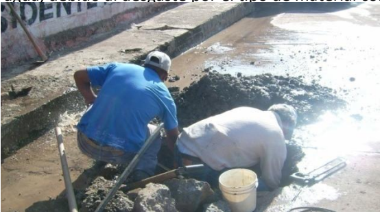
En la parte del interior de la cabecera 29 se han reparado y sustituido por tomas nuevas domiciliarias de agua, debido al desgaste por el tipo de material con el que cuentan.
