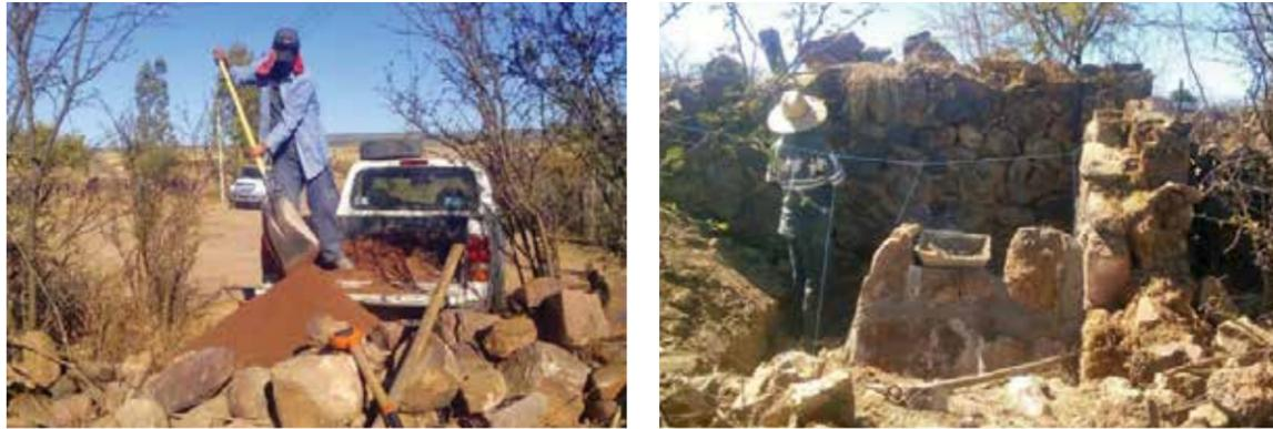
**Construcción de base de 2.2 x 2.2 metros para cisterna de 5000 litros a base de mampostería de piedra con losa de concreto simple 0.80 metros de alto aproximado.**
