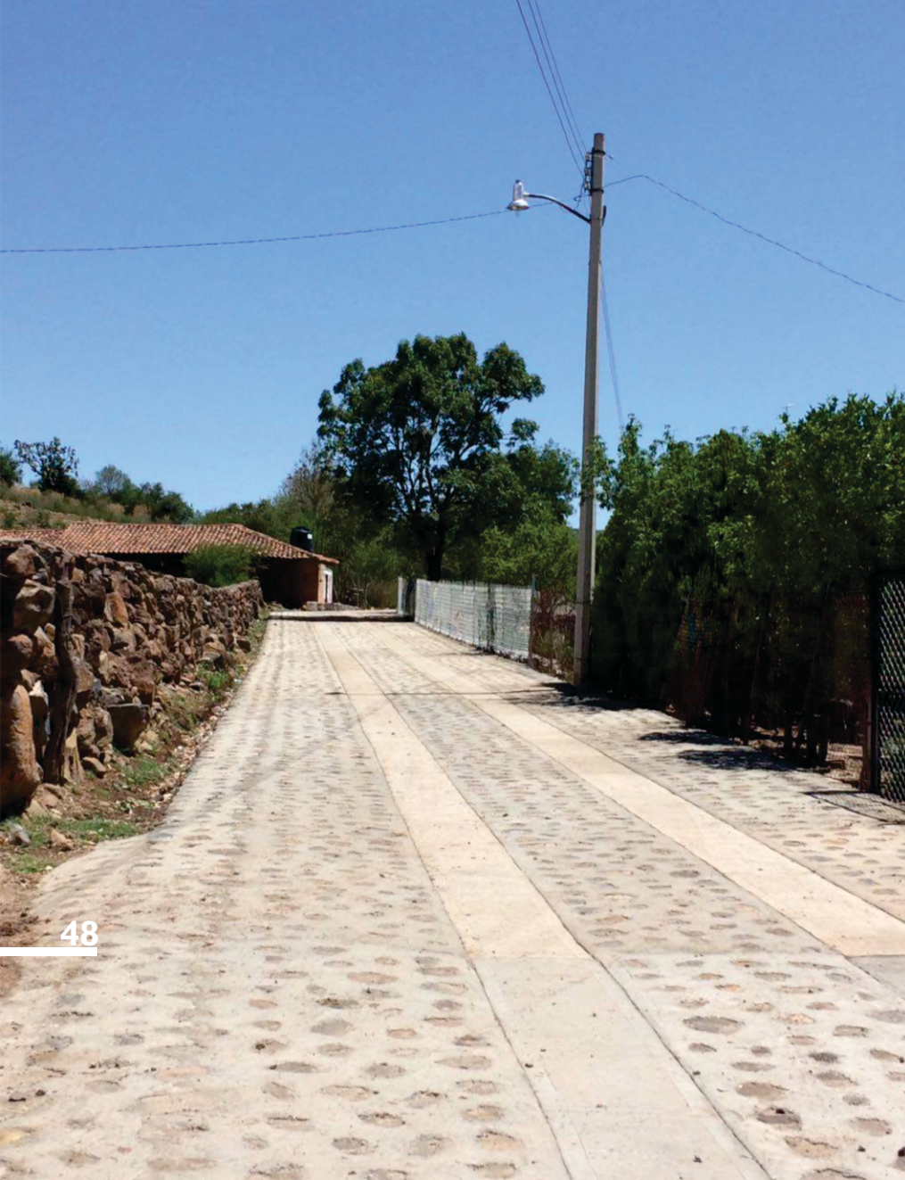
EMPEDRADO AHOGADO EN CONCRETO Y RED DE AGUA POTABLE Y ALCANTARILLADO EN CALLE PRINCIPAL DE LA LOCALIDAD DE LA SABINILLA
