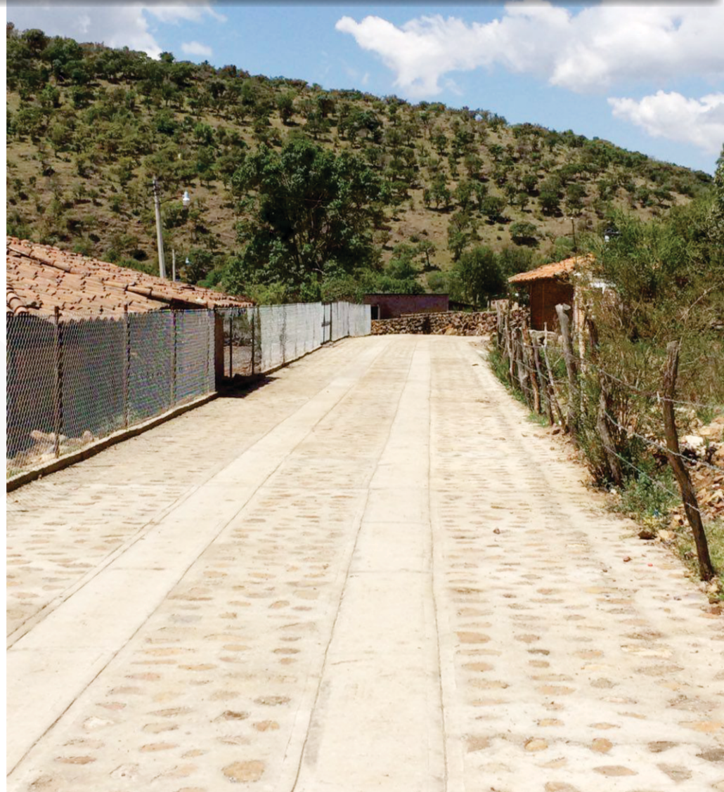
EMPEDRADO AHOGADO EN CONCRETO Y RED DE AGUA POTABLE Y ALCANTARILLADO EN CALLE PRINCIPAL DE LA LOCALIDAD DE LA SABINILLA
