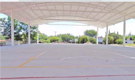
Cofradía: Construcción de cancha de usos múltiples
