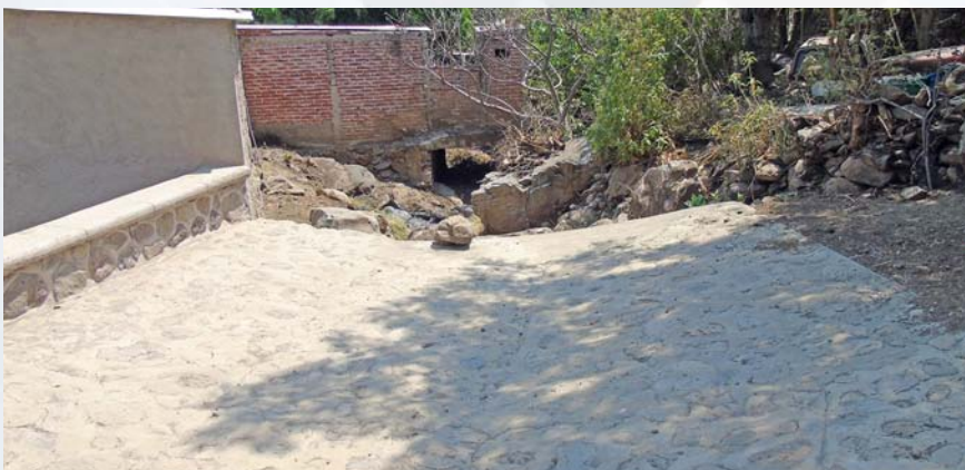
— Construcción de vado, y drenaje en la calle Morelos de la Delegación Tepec. Inversión: $ 79,000.00
