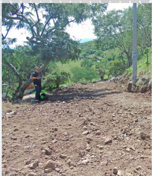
— Construcción de camino al panteón prolongación Nicolás Bravo, Delegación de Tepec.- Los migrantes radicados en Los Estados Unidos liderados por Nena López apoyaron con mano de obra Inversión: $ 160,000.00
