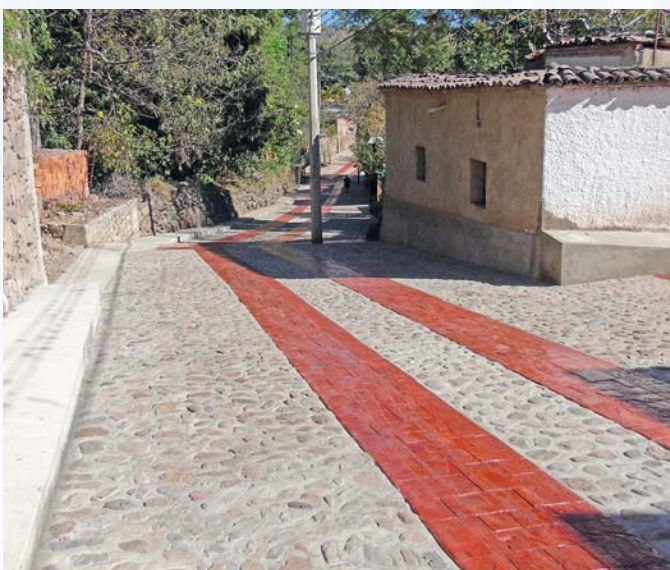
— Rehabilitación de redes hidrosanitarias, empedrado ahogado en concreto con huella de rodamiento en la calle Independencia, en Amacueca. Inversión: $769,482.00
