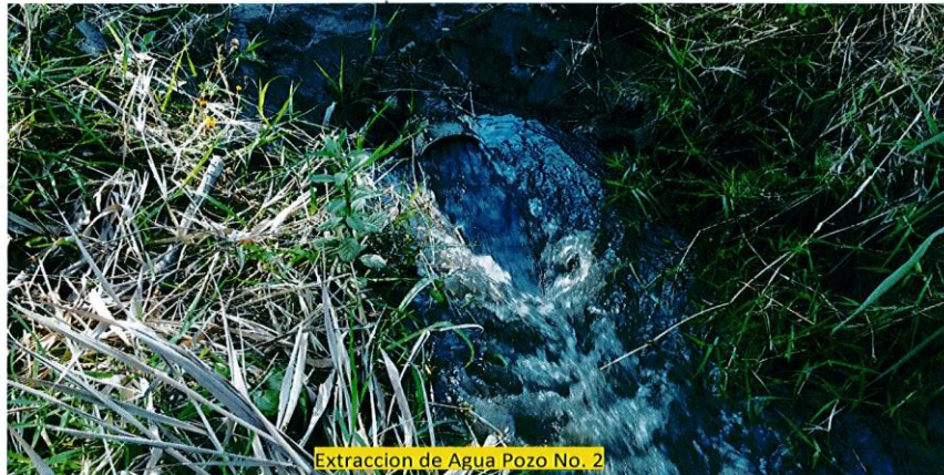
Extracción de Agua Pozo No. 2
