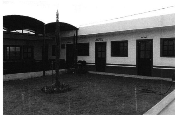
Ampliación del DIF Municipal
