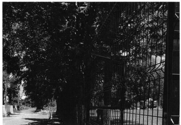
Construcción de cancha de Usos múltiples
