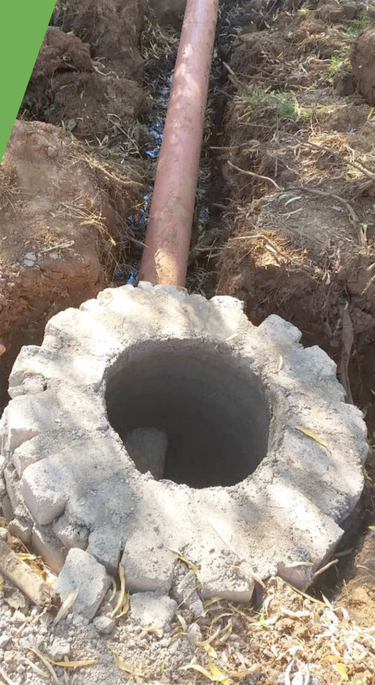
Construcción de red de drenaje y callejón "La Manzanilla" en piedra ahogada en concreto, en La Manzanilla de la Paz, Jalisco
