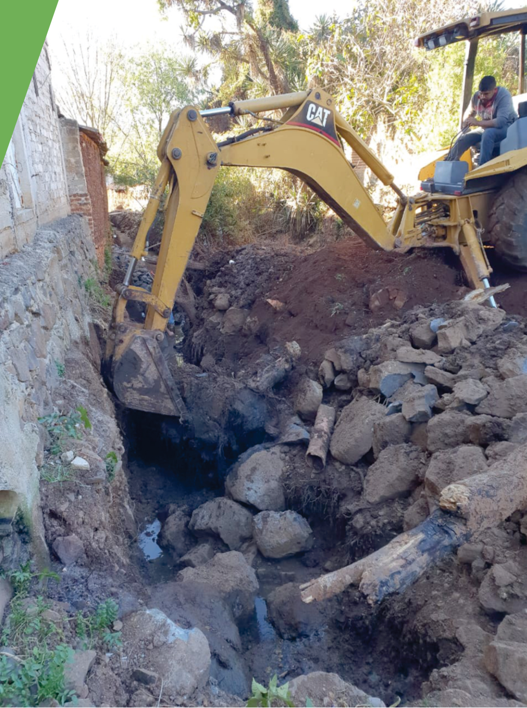
Costrucción del colector de aguas negras en el río a un costado calle Ramón Corona, en la cabecera municipal de La Manzanilla de la Paz, Jalisco. (1er etapa)
