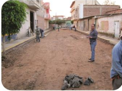
2.- Construcción de pavimento de concreto hidráulico en la calle Francisco Márquez de la cabecera municipal de Tizapán el Alto, Jal.
