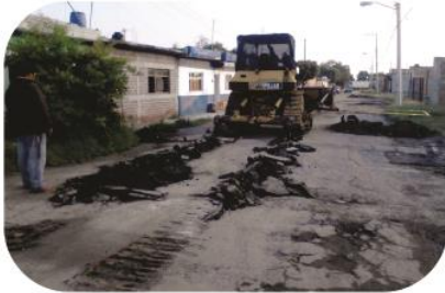
3.- Construcción de pavimento de concreto hidráulico en la calle Mexico de la cabecera municipal de Tizapán el Alto, Jal.
