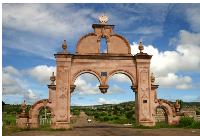
FUENTE: Archivo fotográfico de Ramón Flores Gómez. Arcos de ingreso a la Delegación de Temastían
