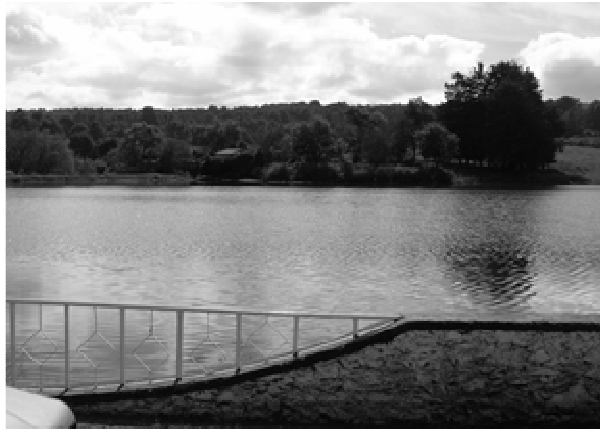
Presa “EL CHIFLON”, ubicada a una de las orillas de la cabecera municipal.
