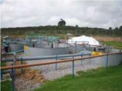
La infraestructura de la planta permite el tratamiento primario y secundario de las aguas. Además, se construyó en la planta un tanque de desinfección y un canal a cielo abierto con medidor Parshall.
