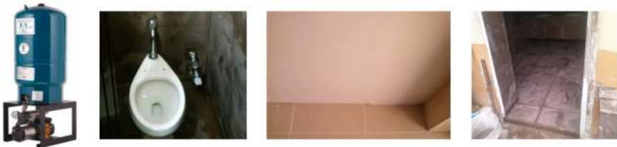
Se colocó Hidroneumático para mejor flujo del Agua Potable y se remodeló de Piso a Vitropiso. Obras como esta benefician al Personal Docente y principalmente los Alumnos, pues les hará más accesible el Desarrollo de sus necesidades básicas y con un aspecto digno.
