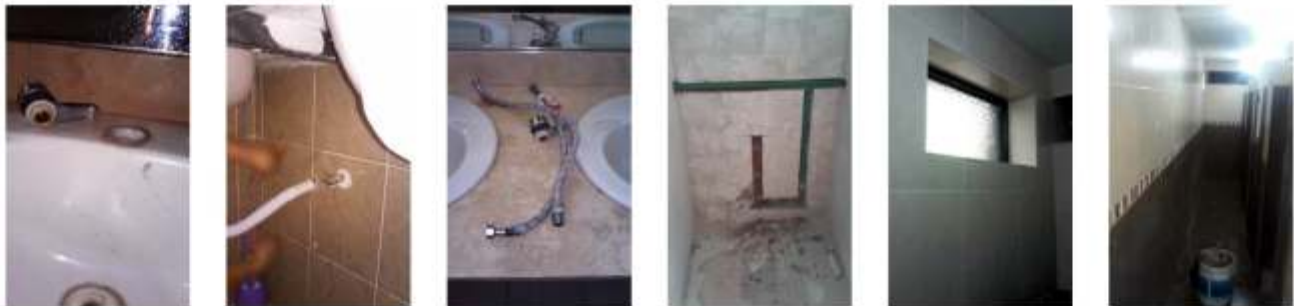
Remodelación de Llaves, Mangueras y Conexión de Agua a los Lavamanos. Sustitución de Tubería de Agua Potable en Baños. Creación de Ventana de 30 x 60 cm, con vista al Patio Cívico. Pintura en Puertas y Techo de los Baños. Se colocaron 4 Fluxómetros en Tazas para el baño.
