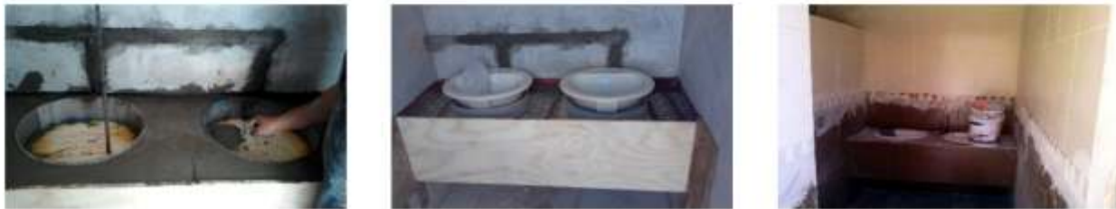
Sustitución de Tazas de Baño y Lavamanos, además de creación de una Barra de concreto de 2.0 x .50 m
