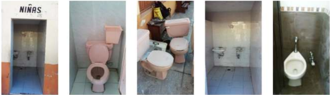
Sustitución de Tazas de Baño y Lavamanos, además de creación de una Barra de concreto de 2.0 x .50 m
