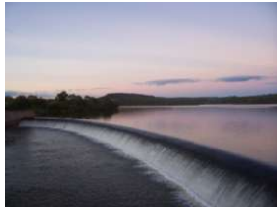
Ilustración 4: Vertedor de la presa de Tacotán
