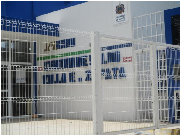
VISTA DEL EQUIPAMIENTO INSTITUCIONAL DE NIVEL BARRIAL/EI-B CORRESPONDIENTE A LA CASA DE SALUD EN LA LOCALIDAD VILLA EMILIANO ZAPATA (EJIDO MODELO)
