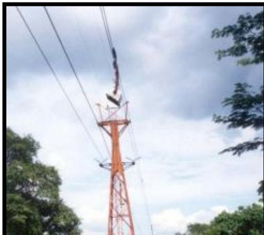
Teleférico que transporta el mineral de la mina "El Encino" a la planta peletizadora de estación Alzada
