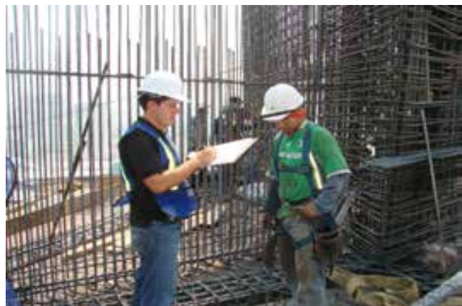
Obra en construcción realizada en el municipio de Guadalajara, Jalisco.
