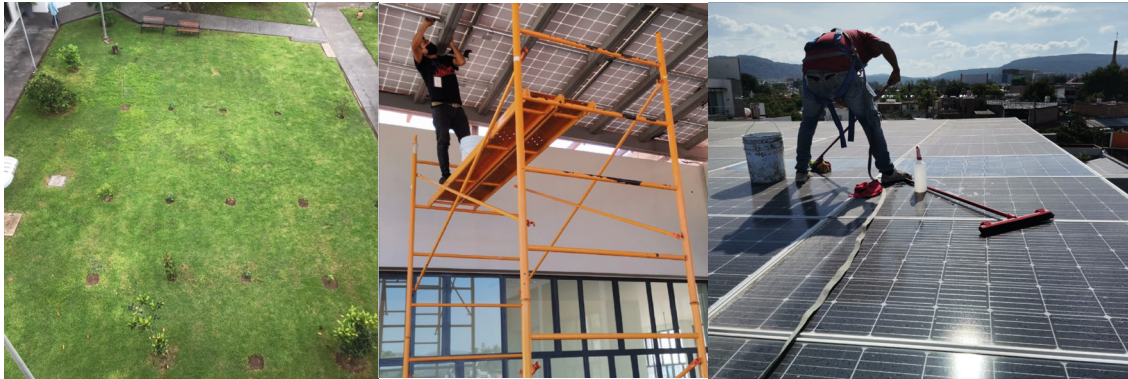
Imagen 29. Mantenimiento preventivo a las instalaciones del IIEG durante 2020
