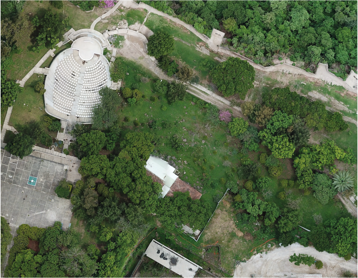
Imagen 23. Imagen aérea del Parque Huentitán.
